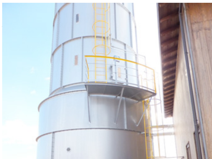
燃料供給装置
